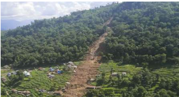
फोटो : Parbat Landslide 2020
