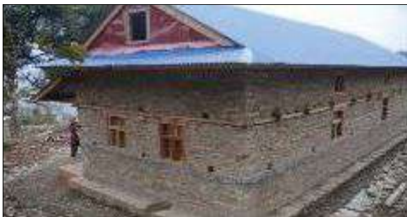
फोटो : परम्परागत निर्माण प्रविधिमा परम्परागत तथा आधुनिक निर्माण सामग्रीको मिश्रण
